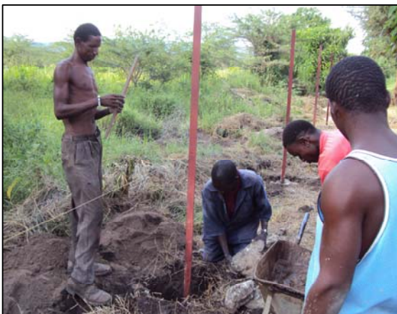
Het plaatsen van de palen van het hekwerk.
