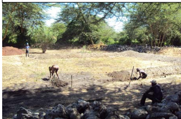
Het graven van de fundering.
