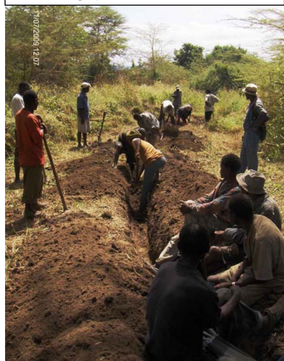
Aansluiting op het bestaande waternet.
