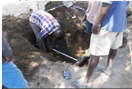
Aansluiting op het bestaande waternet.
